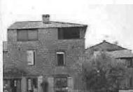
Maison contemporaine en pierre et béton pour les linteaux et encadrements. Même typologie que la maison ancienne avec comble aménagé en terrasse et loggia.
